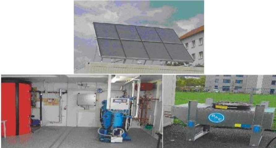
الشكل (1-4) منشأة تجريبية لآلة تبريد امتصاصية شمسية.
