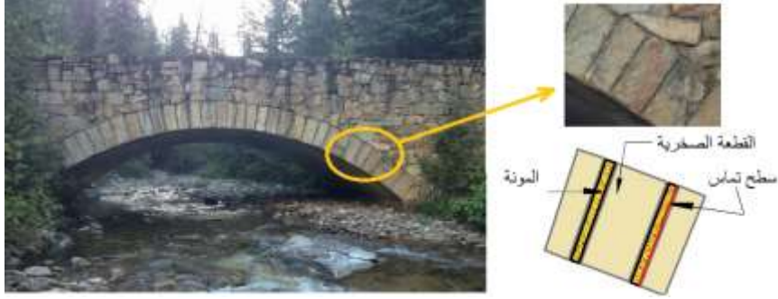
الشكل (5) مكونات المادة الحجرية (Masonry) المستخدمة في بناء الأقواس الحجرية 4 - الدراسة المرجعية :
