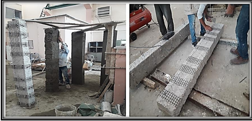
الشكل (7) كيفية تدعيم الجوائز حول محيطها وعلى الوجهين الجانبيين
