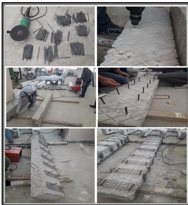
الشكل (6) تجهيز وتركيب روابط القص والبراغي الجاهزة
