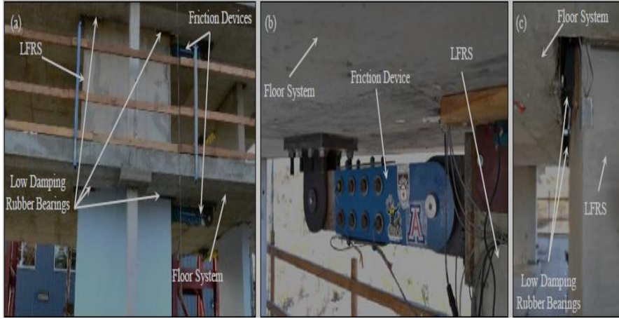
الشكل [4]: توضع مكونات الوصلة ضمن مبنى بيتوني مسلح.
