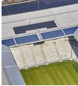
ألواح شمسية لتوليد الطاقة سقف ملعب بوردو (فرنسا)
