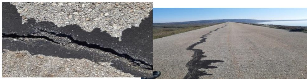
الشكل (2) يوضح التشققات الطولية على قمة السد
