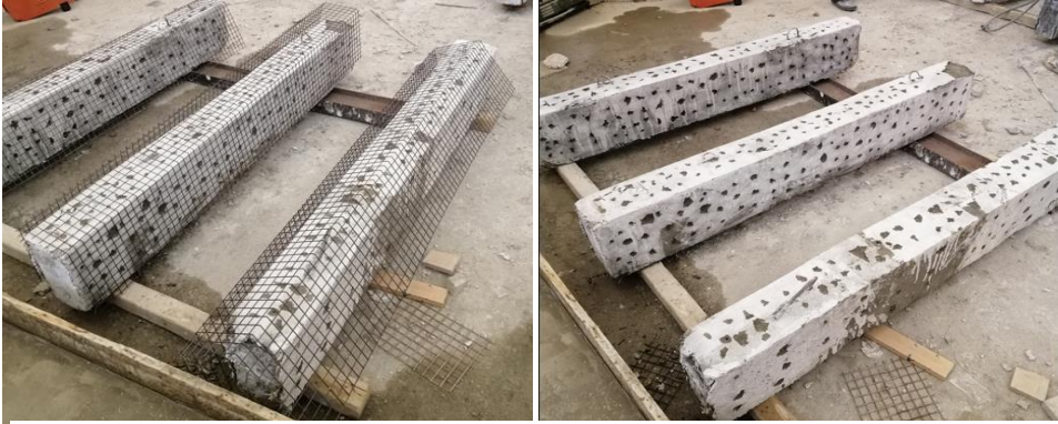
الشكل (5) مراحل تنفيذ ثقوب روابط القص وتثبيت شبك الاسلاك
