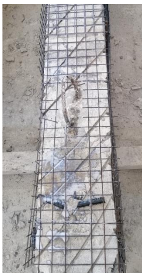
الشكل (4) مراحل تنفيذ الروابط باستخدام SBR ووباستخدام روابط القص وتثبيت شبك الاسلاك
