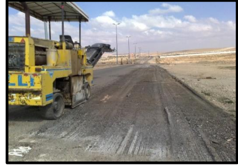
الشكل رقم (4) عمليات كشط طبقة الاسفلت السطحية
