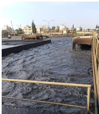
الشكل (3-6): حوض المعالجة البيولوجية الشكل (3-7): حوض الترسيب
