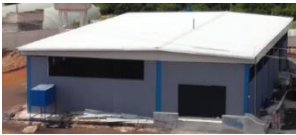
الشكل (3): سقف بألواح سندويشية لمعمل محلي
