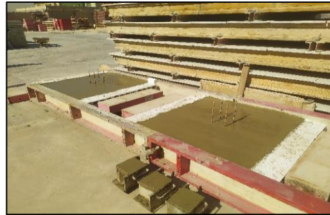
الشكل (8): مراحل عملية صب البلاطات
