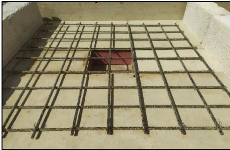
الشكل (8): مراحل عملية صب البلاطات
