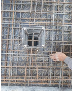
الشكل (13) تسليح العينات المقواة
