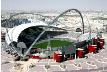
الشكل (6) هياكل كابلية معلقة على شكل جائز (شادة)
