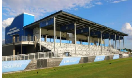
الشكل(4) نظام الإنشاء الهيكلي (الجائز والعمود)
