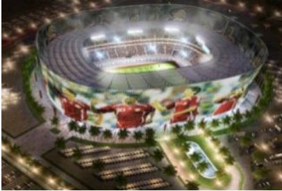
الشكل (20) شاشة عرض رقمية على كامل واجهة ملعب الريان في قطر. المرجع [24]
