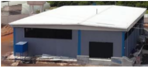
الشكل (3): سقف بألواح سندويشية لمعمل محلي
