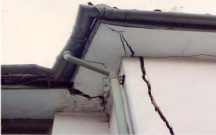
الشكل [1] بعض الآثار السلبية للتربة المنتفخة
