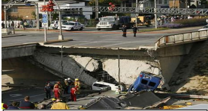
الشكل (4): انهيار جسر لافال بسبب فشل القص [5].
