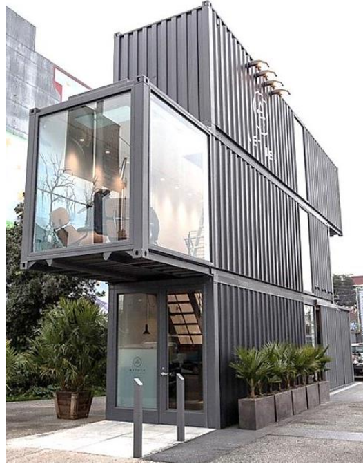
تراكب الحاويات لتظليل وتمييز المدخل
