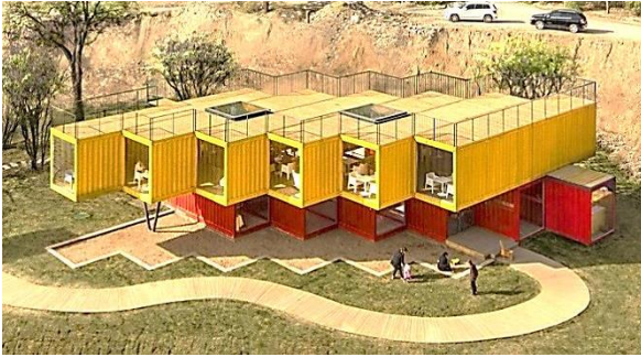
كتلة الجناح توضح توضع الحاويات الصفراء المتعامدة مع الحمراء، والظلال الناتجة
