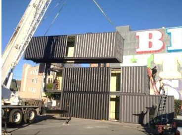
تركيب المبنى بالموقع
