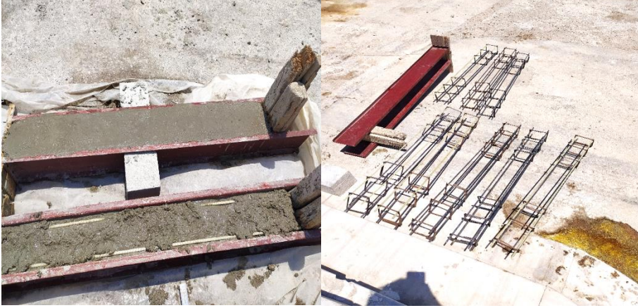
الشكل (8) : تحضير فولاذ التسليح لجوائز الاختبار الشكل (9) : صب الجوائز البيتونية
