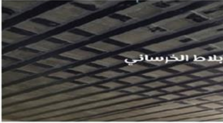
التدعيم باستخدام صفائح فولاذية
