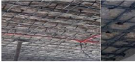
التدعيم باستخدام شبكة من القضبان الفولاذية
