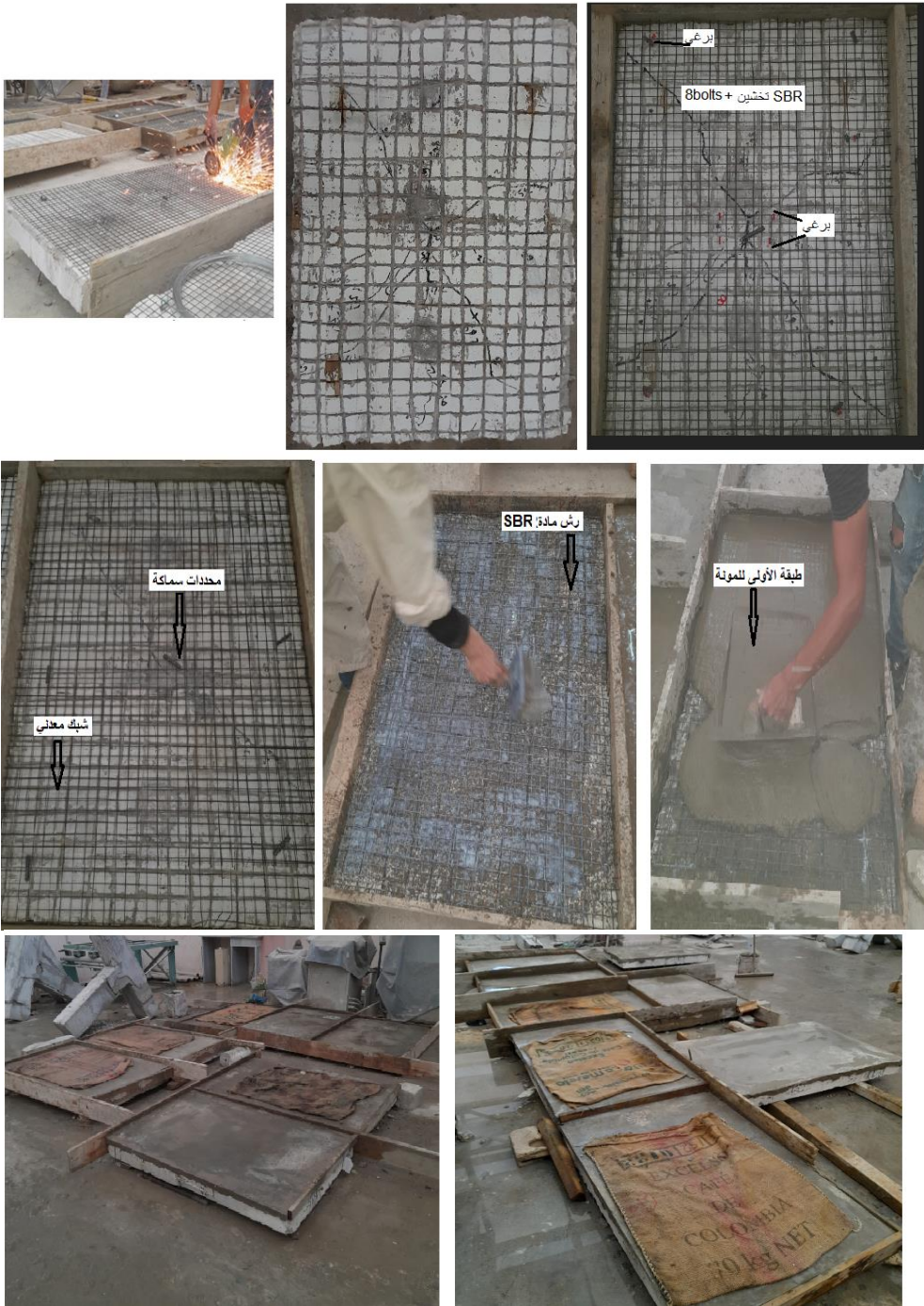
الشكل (23) إجراءات التدعيم للبلاطات المتضررة بلهب النار وفق أنماط الترابط المختلفة
