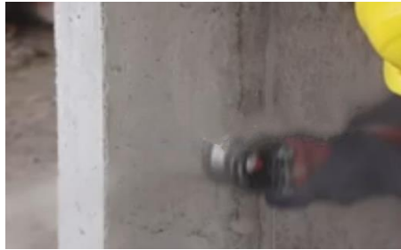
الشكل (43) تنظيف الطبقة السطحية للعقدة.
