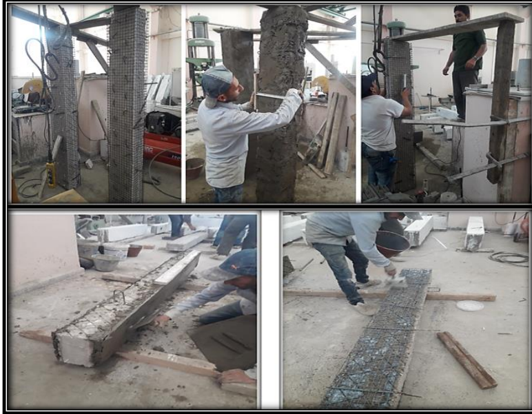
الشكل (6) كيفية تدعيم الجوائز حول كامل محيطها وعلى الوجهين الجانبيين
