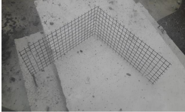
الشكل (47) الشبك المعدني المستخدم في زوايا العقد
