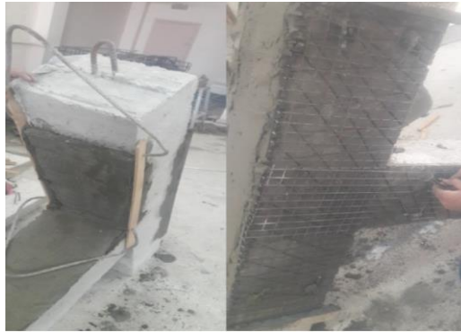
الشكل (48) مراحل تنفيذ التدعيم
