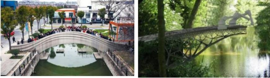
الشكل (20): نموذج جسر باستخدام 3D Printer Robot /يمين، جسر الصين /يسار
