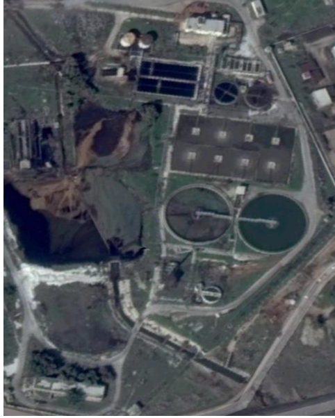
الشكل (3-9): لقطة جوية لمحطة معالجة المياه الملوثة في مصفأة حمص
