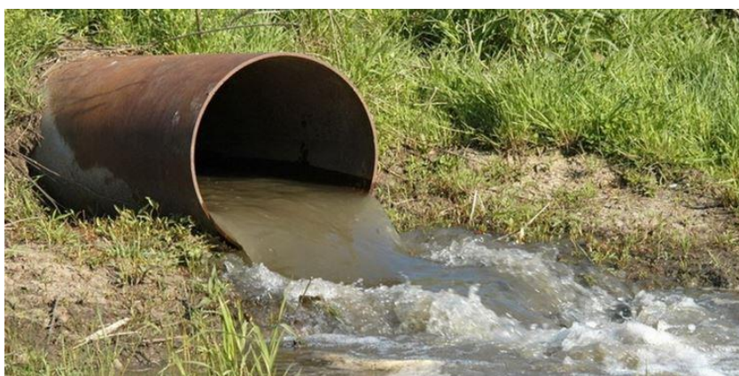
الشكل (3-8): مخرج المياه الناتجة عن محطة المعالجة إلى نهر العاصي
