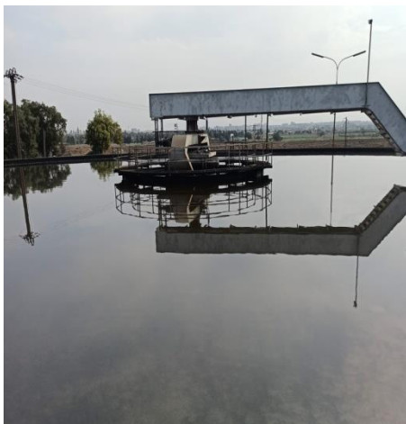
الشكل (3-6): حوض المعالجة البيولوجية الشكل (3-7): حوض الترسيب
