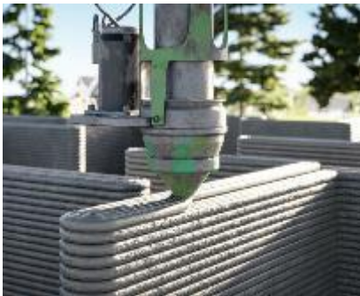
الشكل 7: عملية طباعة الجدار عن طريق بثق الخرسانة من فوهة الطابعة [22]
