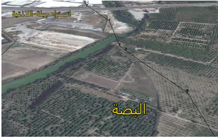
الشكل (6): جزء من مسار خط نقل طاقة كهربائية (التوتر 66kV) (خط اللاذقية - الحفة) اعتماداً على تكنولوجيا الاستشعار عن بعد ونظام ArcGIS (التحليق ثلاثي الأبعاد).
