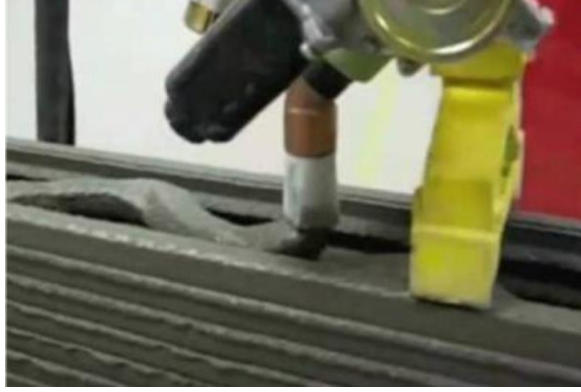
الشكل (2) يبين رأس الطباعة في طباعة الجدران ثلاثي الأبعاد [1]
