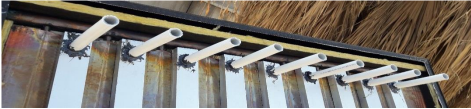
الشكل (10) تثبيت انابيب البلاستيك مع القنوات
