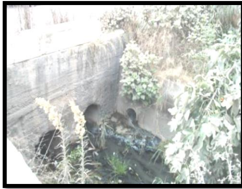
الصورة:(22): مخلفات الصرف الصحي في منطقة البحث الصورة:(23): الصرف الصحي إلى نهر الدامات. ( تصوير الطالبة).
