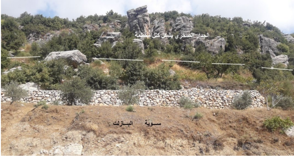
الشكل رقم 22: الجدار الصخري المحطم بشكل كتلاً ضخمة فوق سوية البازلت في منخفض الرصافة.
